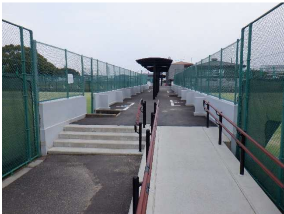
日よけ・スロープ・車いす観覧席設置
