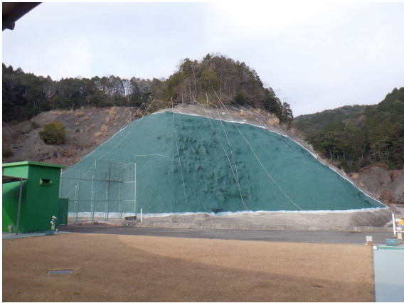
スキート射撃場法面（整備中）
