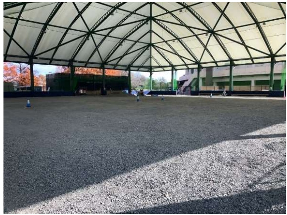
屋内運動施設：内観（整備中）
