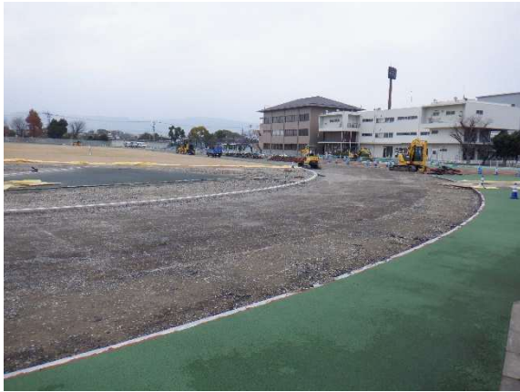
舗装補修（整備中）
