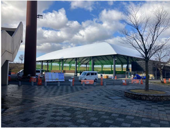
屋内運動施設：外観（整備中）
