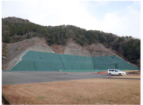
トラップ射撃場法面（整備中）
